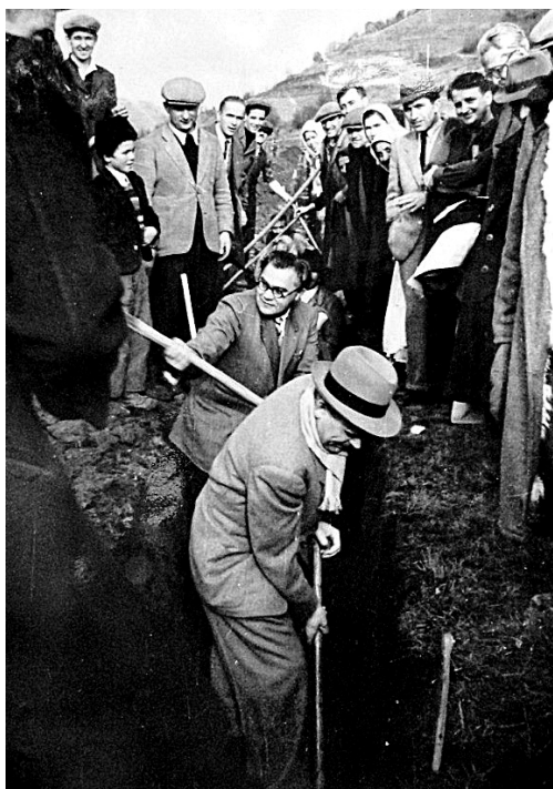
II.6 Vizita de lucru pe șantierul de la Agnita-Botorca a unei delegații a Partidului Comunist
