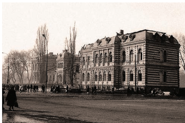
III.9 Spitalul Brâncovenesc din București înainte de demolare.
